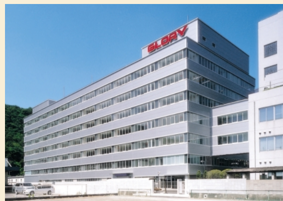
開発棟の全景
