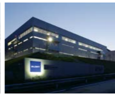
姫路パーツセンターのLED照明
